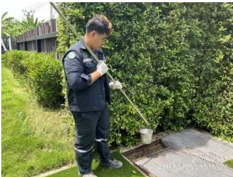
บ่อพักน้ำทิ้ง ก่อนระบายสู่ท่อระบายน้ำสาธารณะ
